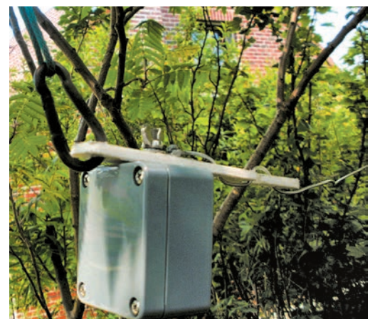
Trafo op z'n plaats en constructie
